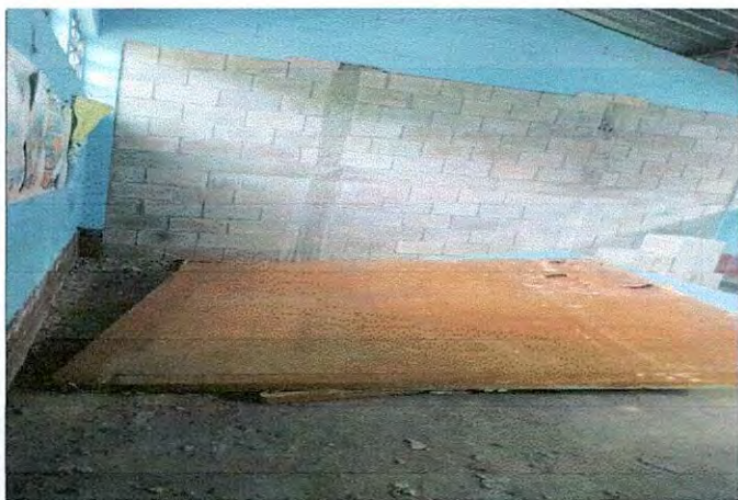
Foto 3: Demolición de piso rústico
