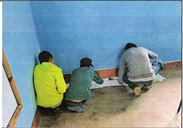
Foto 2: Pintado interior de aula.
