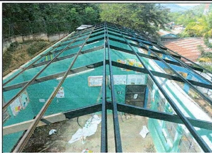
Foto 2: Mantenimiento a las costaneras 9lijado y pintado)
