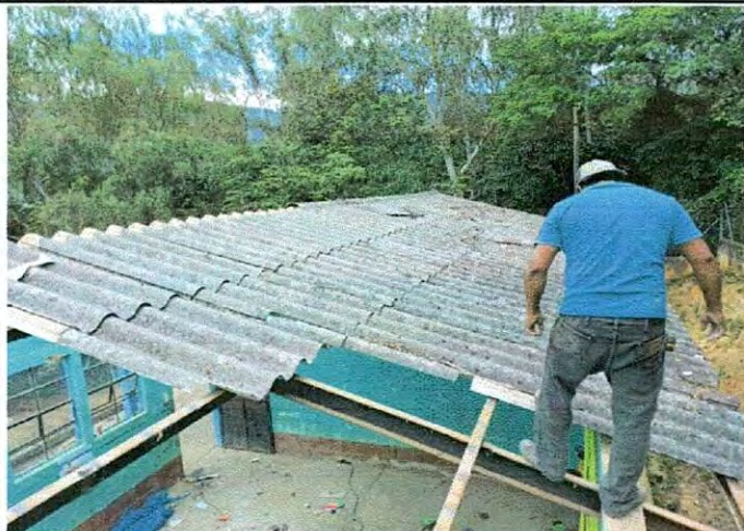
Foto1: Retirando el techo de duralita.
