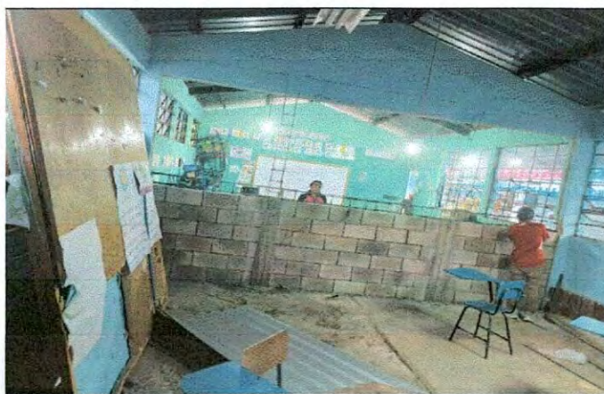
Foto 3: Inicio de colocación de block.
