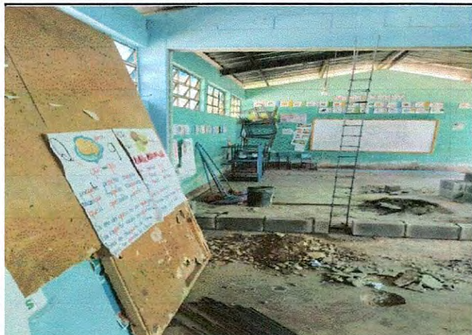
Foto1: Retiro de la división de aula de madera.
