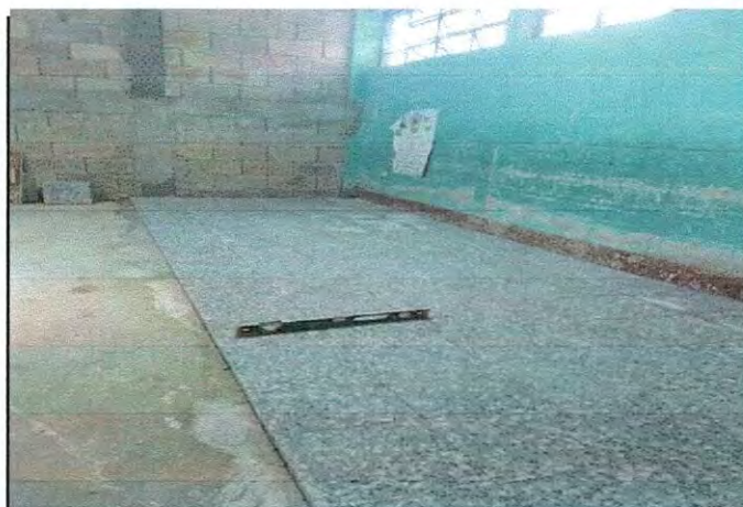
Foto 4: Colocación de piso de granito.
