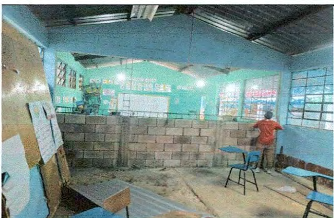
Foto 4: Fundición de columnas,
