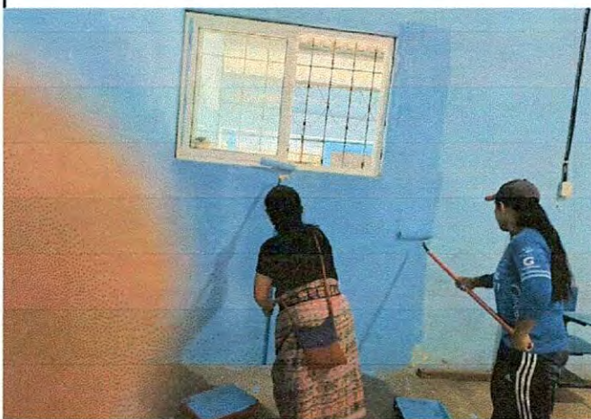
Foto1: Pintado interior de aula.
